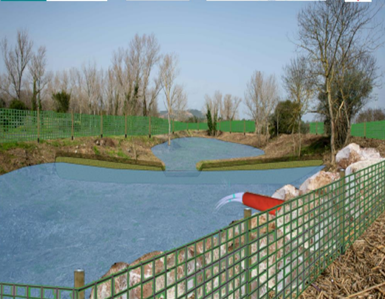
RENDERING VASCA DI SEDIMENTAZIONE E INFILTRAZIONE
