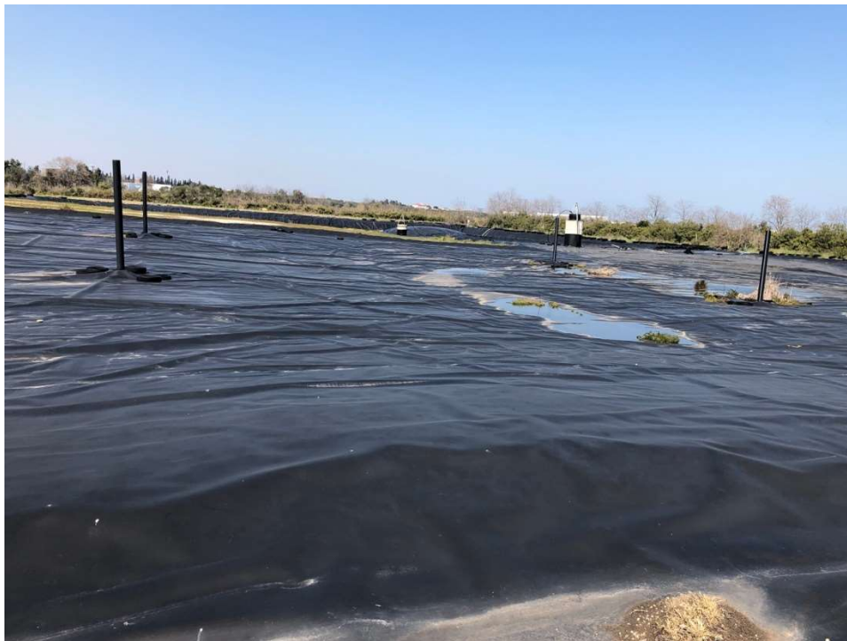
Figura 1. Ex discarica Rocca S.Giovsnni (foto sopralluogo del 27/07/23)
