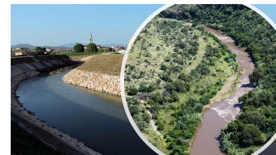
Manutenzione ordinaria di canali
